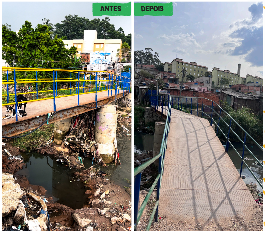
Manutenção da Ponte Souza Ramos do Jd. Pedra Branca
